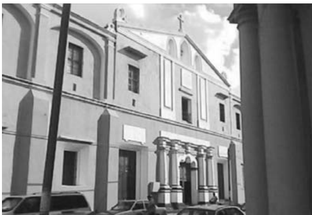
Figura 2. Último hospital construido durante la colonia en el Puerto de Veracruz, con el nombre de Hospital de San Sebastián y posteriormente Aquiles Serdán, hasta su cierre en 1986.
